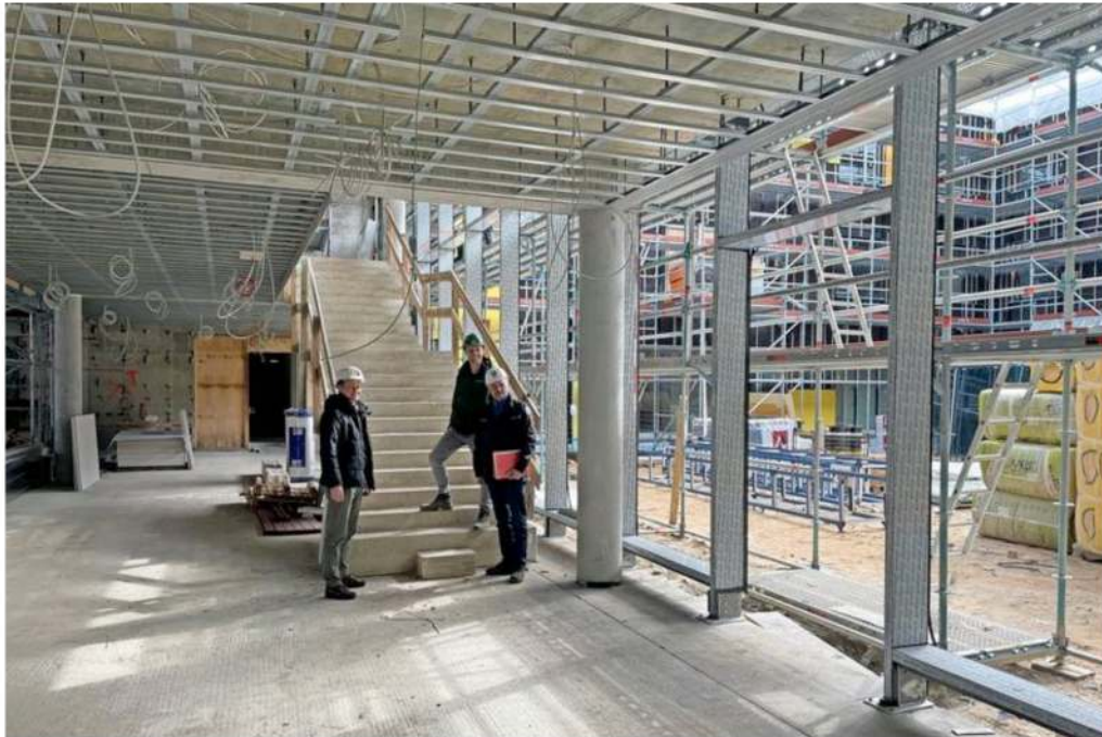
Stauten nicht schlecht beim Rundgang durch den Rohbau des neuen Gymnasiums am Mühlenberg: Bürgermeister Uwe Brinkmann (links) und Bauamtsleiter Thomas Sablowski (rechts). Projektleiter Janne Zunker-Daberkow von der Firma Otto Wulff führte über die Baustelle. Quelle: Sebastian Prey
