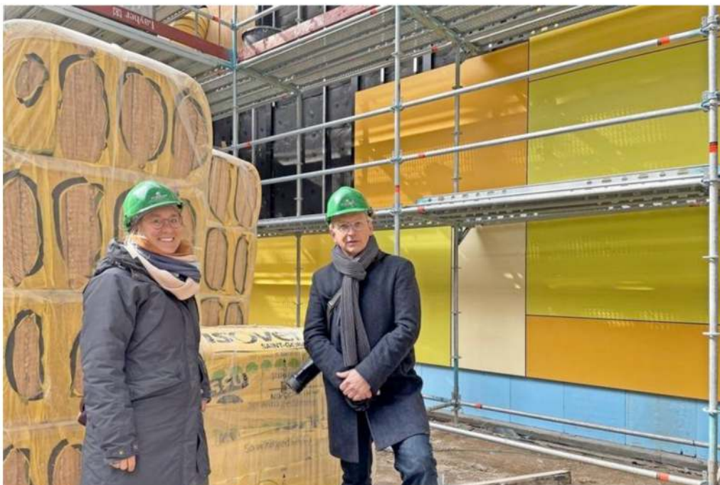
Die Architekten Johanna Erbslöh und Tobias Engelhardt bei der Baustellenbesichtigung. Quelle: Sebastian Prey
